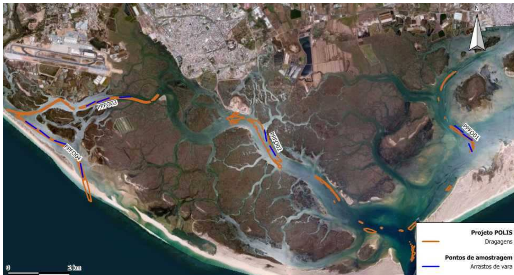
Desenho 2 – Localização dos transetos de amostragem de monitorização da comunidade piscícola.
